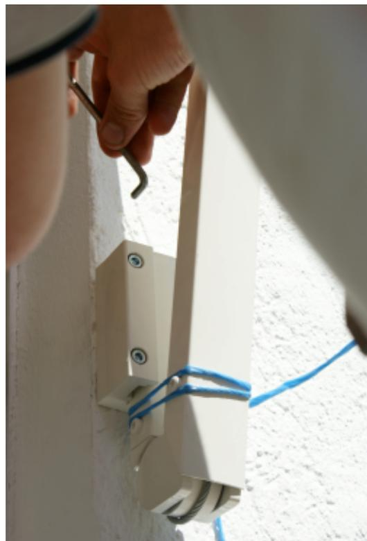
Schritt 6: Halten sie eine Wasserwaage an das Ausfallprofil und prüfen sie ob die Anlage gerade ist. Wenn die Anlage im Wasser montiert ist müssen alle Schrauben noch einmal festgezogen werden.
