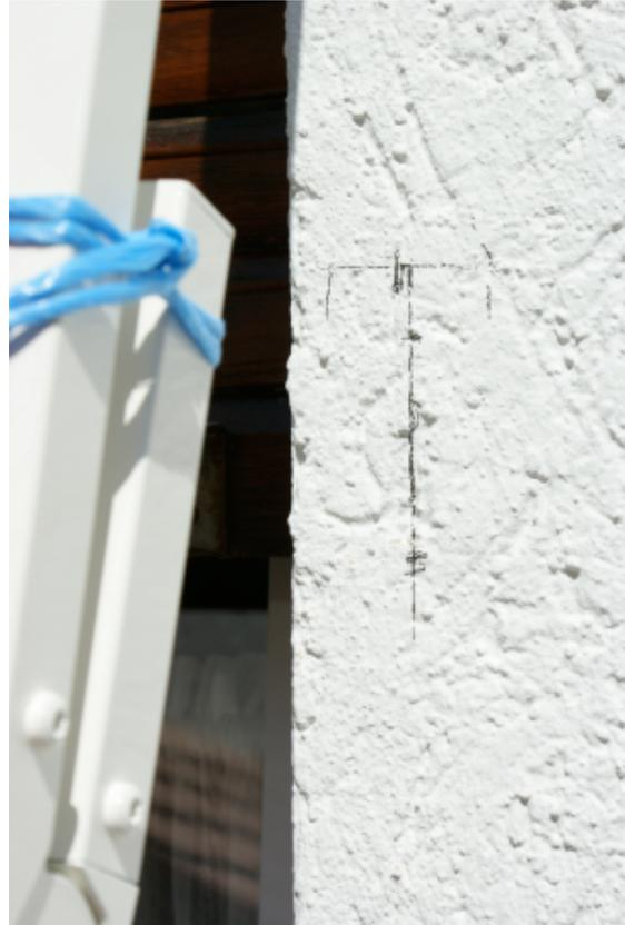
Bohren Sie die Löcher mittig, um gegebenenfalls etwas Spielraum zum befestigen zu haben. Es ist beim Anschrauben darauf zu achten das die Konsolen gerade sitzen. Die Arme nun mit den Klemmbacken sichern. Den Arm andrücken und den Backen aufstecken und festschrauben.
