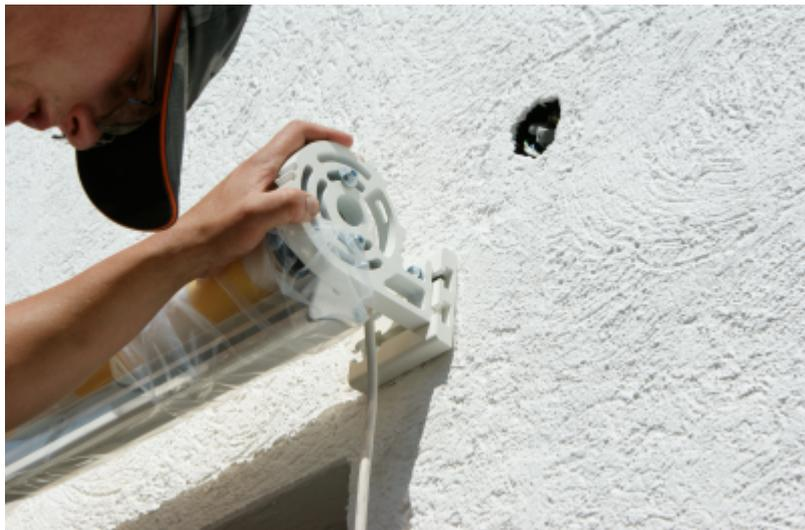
Schritt 4: In Schritt 4 werden die Federarme an der Ausfallschiene befestigt.
