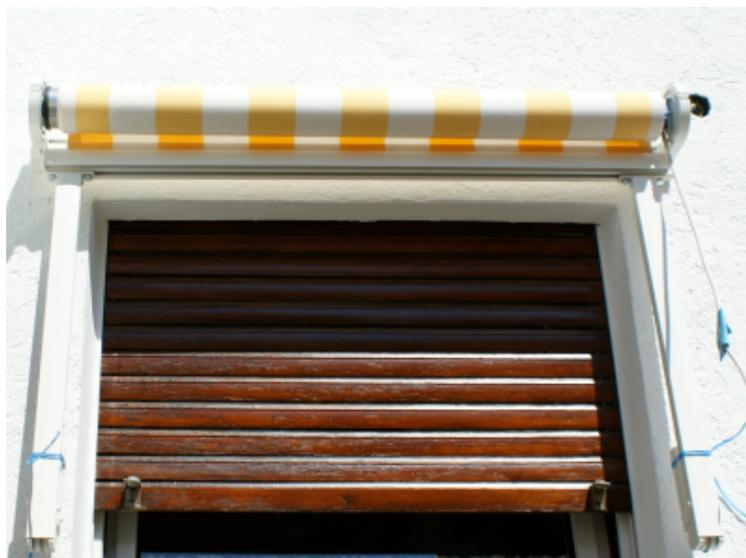
Schritt 5: In Schritt 5 werden die unter Konsolen (Armaufnahme) befestigt. Hierzu die Gelenkarme nach unten hängen lassen und die Anlage nach oben fahren bis die Fallstange ca. 1 cm von der Tuchwelle entfernt ist. Die Arme geben nun den Befestigungspunkt für die Aufnahme vor.
